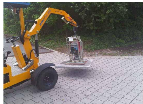
Вградување на La Linia плочки со вакуум машина.
